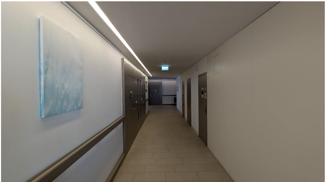
Bild 4: Haus Schirming - Korridor
