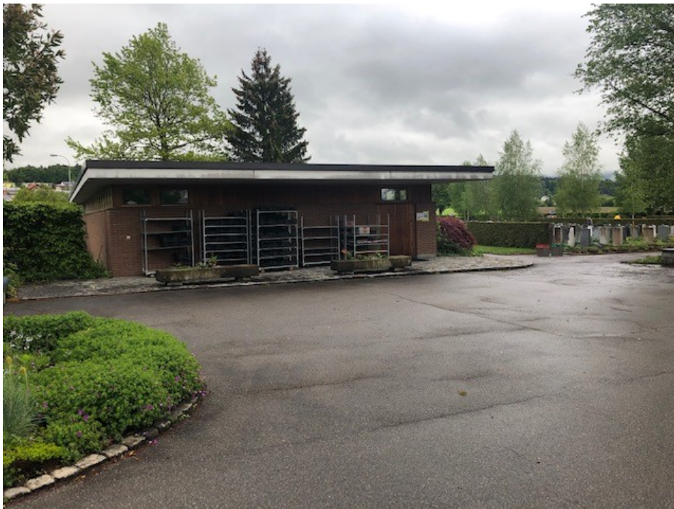
Bild 2: Foto bestehende Leichenhalle
