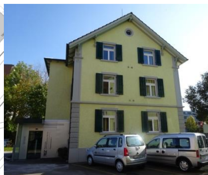
Bild 2: Ansichtsfoto Strassenseite Pappelstrasse 4
